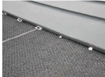
Beispiel für die Verwendung von Dachfolie METALDREN 450 g unter der Überdachung KJG FALZ.
