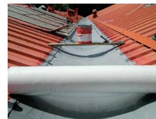
Die Polyestermatte Enke-Polyflexvlies ist eine thermisch verklebte Matte mit einem Gewicht von 110 g/m<sup>2</sup>, Farbe weiß. Sehr gute Saugfähigkeit und Anpassungsfähigkeit an Unebenheiten des Untergrundes. Verwendung mit Enkryl, Enkopur, Enkepren als Einlage, die die mechanischen Eigenschaften der Systeme verbessert.
