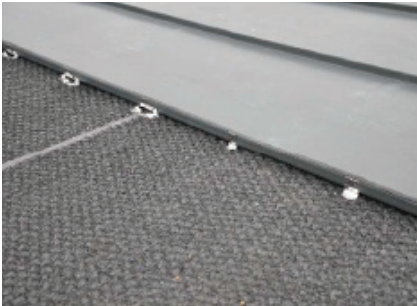
Пример использования кровельной пленки METALDREN 450 г под кровельное покрытие KJG FALZ.
