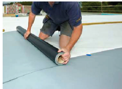
Primeri uporabe geotekstila kot ločevalne plasti pod PVC folijo:
